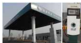
新エネルギー自動車産業パークのすぐ傍に国家电网の電気自動車充電ステーションがほぼ竣工を迎えていた（写真はこれも筆者撮影）
