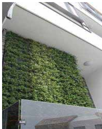
集合住宅への壁面緑化導入例（上海市実践例）
