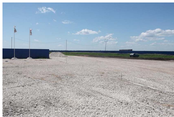
【トリアッチ経済特区の造成工事風景】
