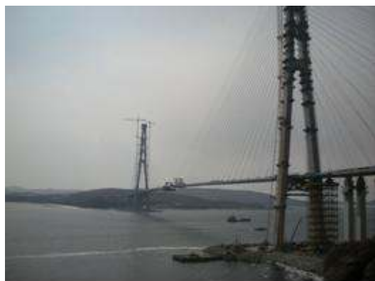
建設中のルースキー連絡橋(2012年3月撮影。向こう側がルースキー島)
