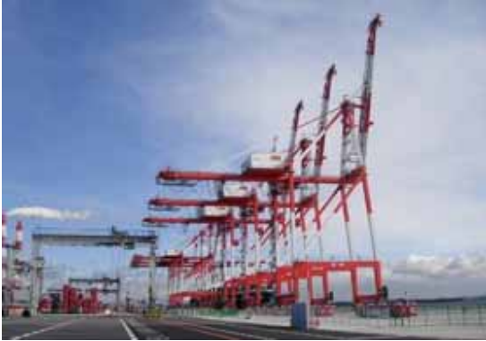
【コンテナクレーンとトランスファークレーン】
