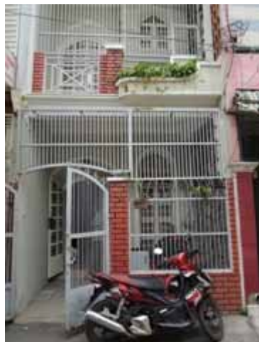
私が見に行った物件の外観。隣の家とは壁を共有している
