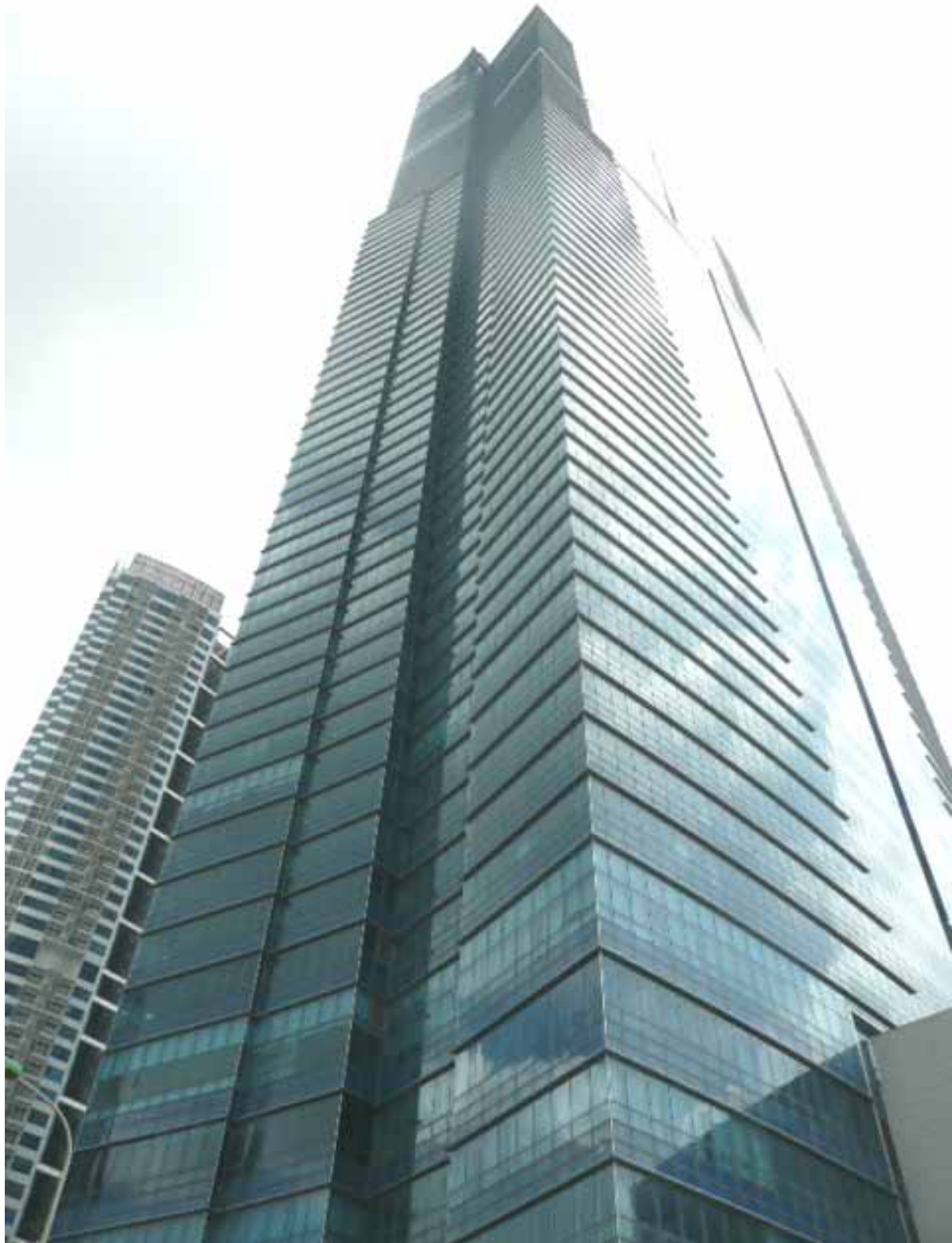
(ベトナム：京南ハノイランドマークタワー)
