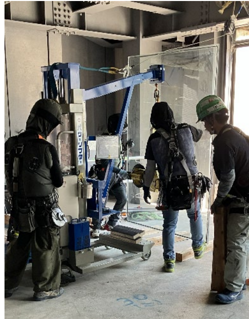
三菱 UFJ 銀行本館解体工事における廃棄窓ガラスの回収工程
