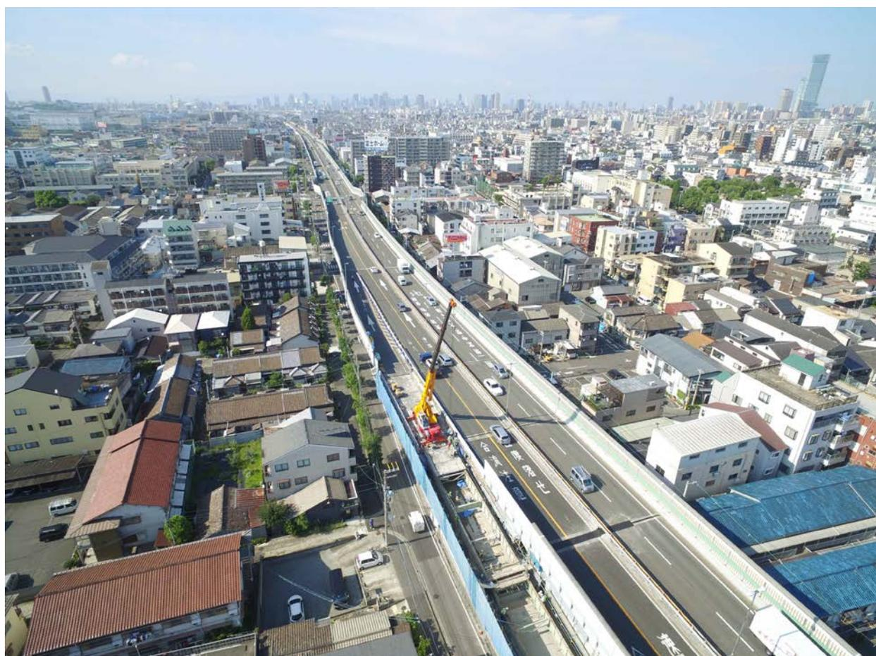
写真-1 床版取替の工事
