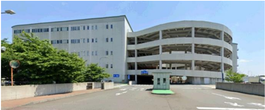
(ロジポート流山B棟)
