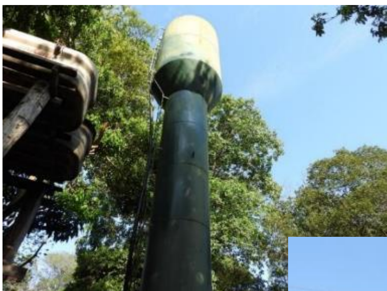
Imagen 25 y 26. Tanques de almacenamiento de agua para los trabajadores y también en las comunidades aledañas.
