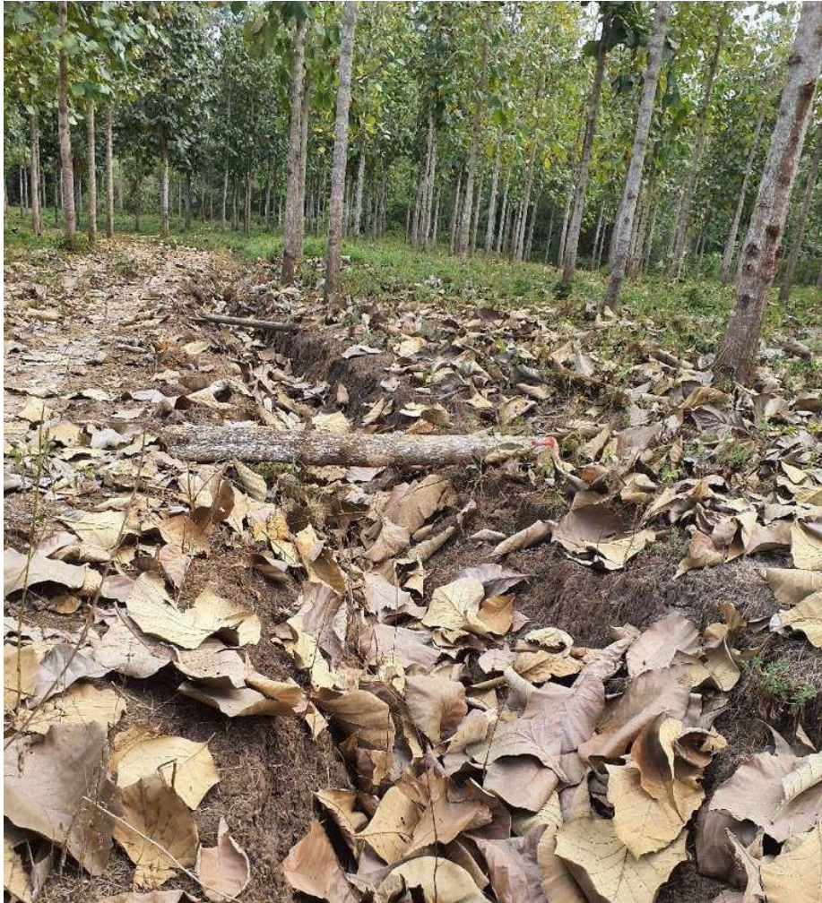
Figura 4 Fotografía de los canales de drenaje instalados
