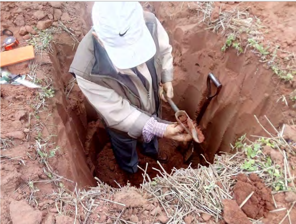
Calicata zona noreste de la propiedad.
