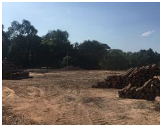
Fotografía 2 - Panorámica del área de acopio
